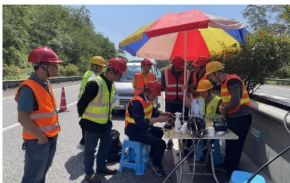
在项目施工过程中,我司接到海外客户反馈,某盘光缆在铺设过程中出现光纤断裂问题。我司高度重视,立即派遣专业售后服务团队前往现场进行技术核查。经全面检测与分析,确认问题源于施工过程中的不当操作导致光缆局部受力打扭。为保障客户项目进度,我司迅速响应,与客户团队深入沟通,明确规范施工标准及操作注意事项,同时协调加急补发同型号光缆1盘,确保施工进度零延误。
